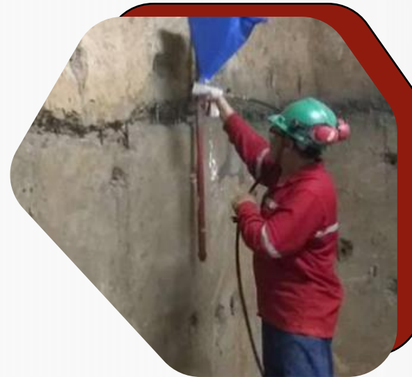
SISTEMA DE INJEÇÃO EPÓXI
