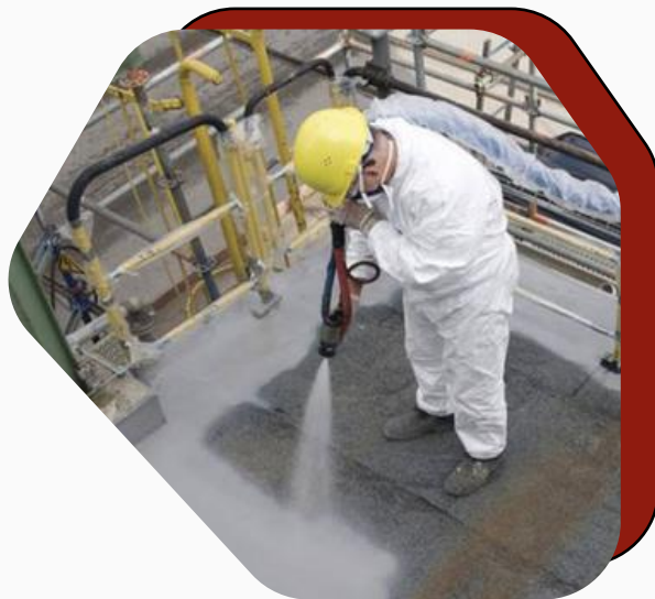
IMPERMEABILIZAÇÃO DE ESTRUTURAS DE CONCRETO
