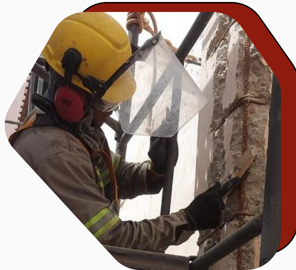
RECUPERAÇÃO ESTRUTURAL CIVIL E MECÂNICA
